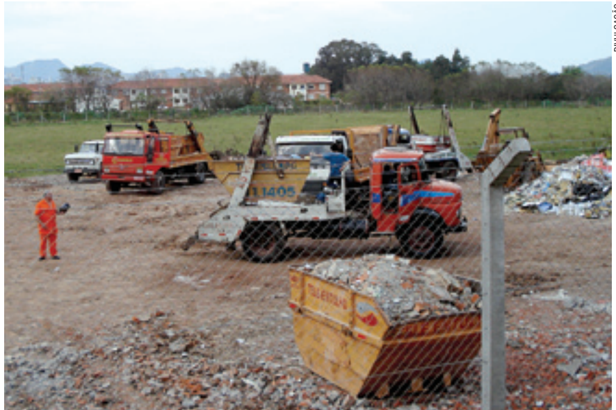
A área da GR2 recebe 40 metros cúbicos de material por dia
